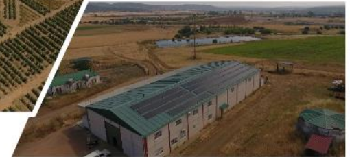
Paneles fotovoltaicos para riego
